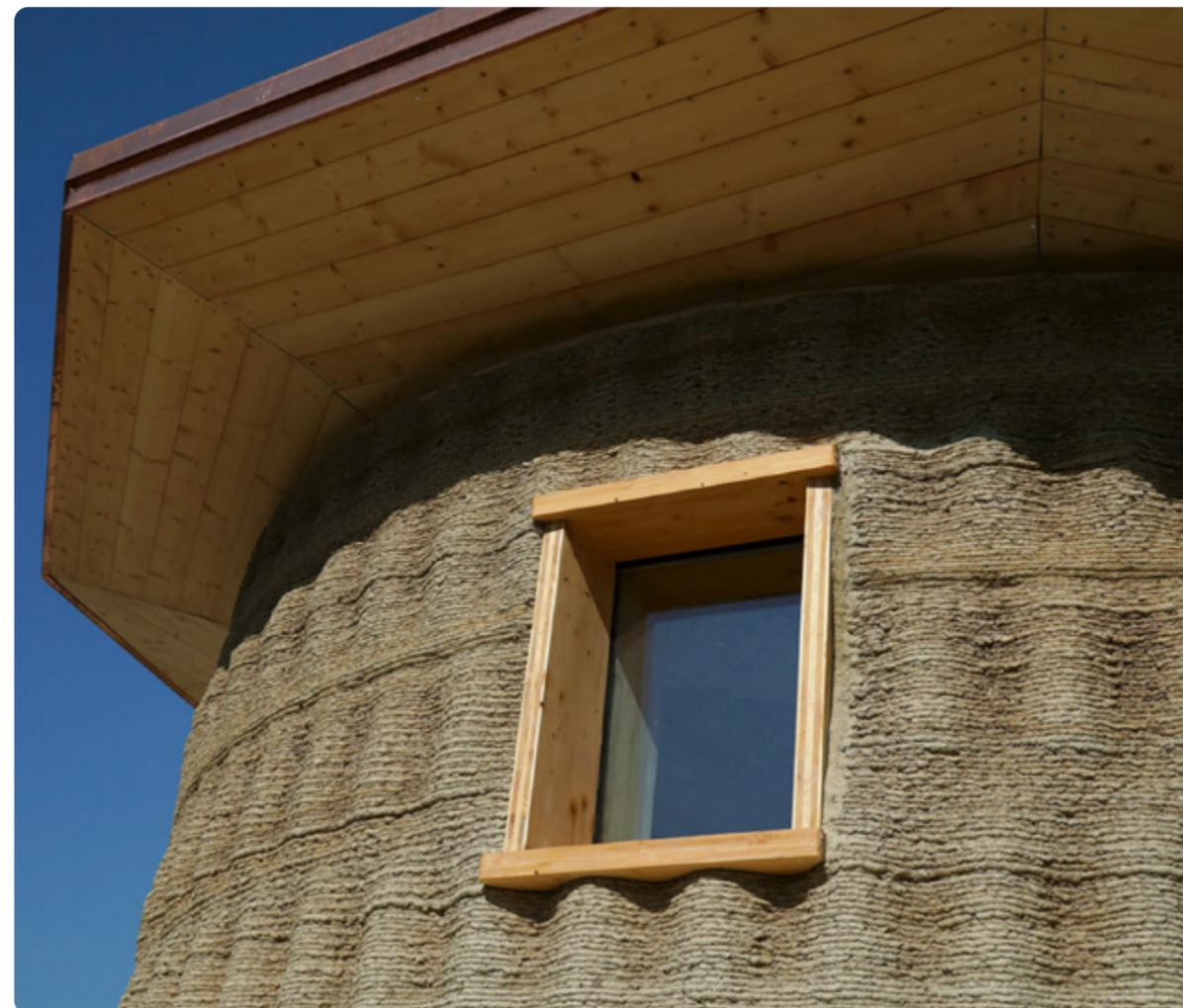
Gaia, di Ricehouse con Wasp: rivestimento in 3D, usando una miscela di argilla, sabbia, paglia di riso e lolla trinciati. Un edificio perfettamente termo-regolato (non necessita di riscaldamento e condizionamento)
